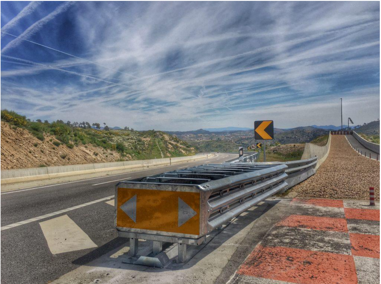
Lavori di messa in sicurezza della strada
